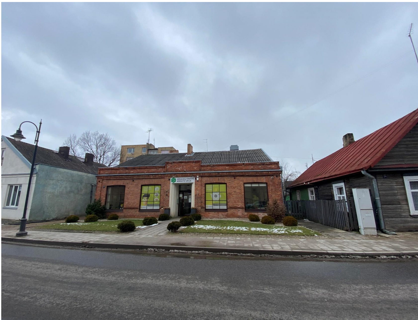
Pastato vaizdas su gretima urbaniztine aplinka (Fotofiksacija iš Josvainių gatvės pusės)
