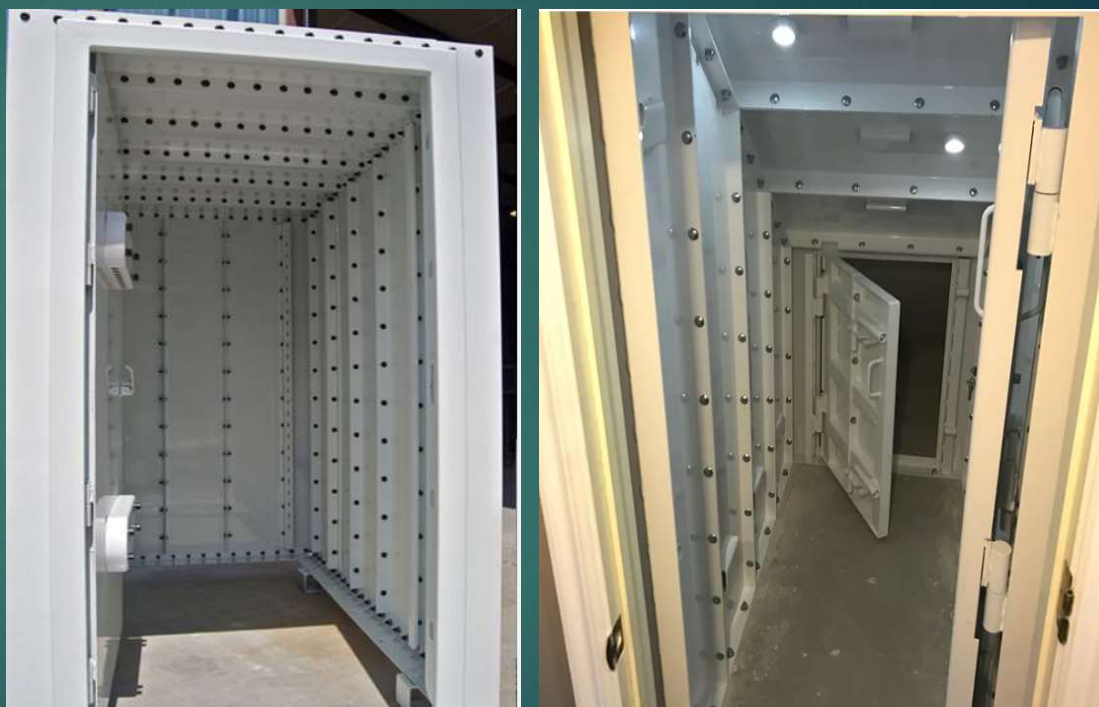
Pav. Pertvarų stiprinimui naudojami plieniniai skydai
