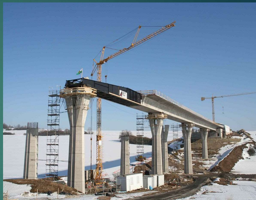
Pav. Inžinerinis statinys - estakada
