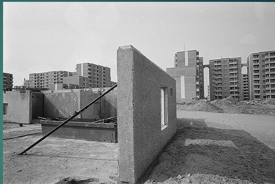
Pav. Stambiaplokščio namo statyba
