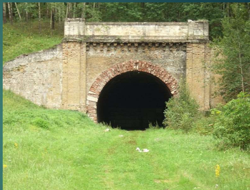
Pav. Požeminis inžinerinis statinys (tunelis)
