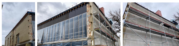
34 pav. Kėdainių šviesiosios gimnazijos pastato rekonstrukcijos darbai
