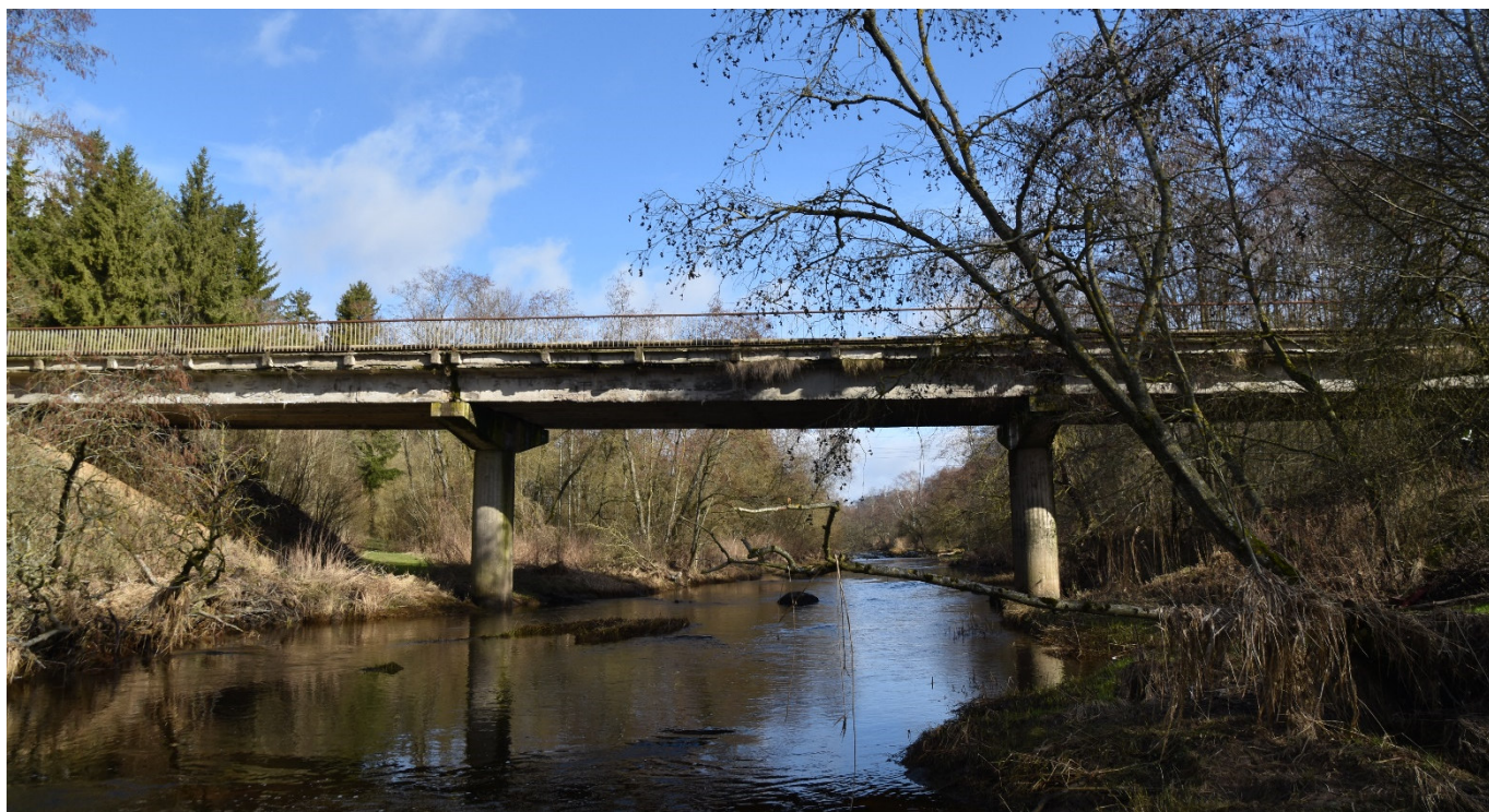
2 pav. Tilto per Šušvės upę fasadinis vaizdas
